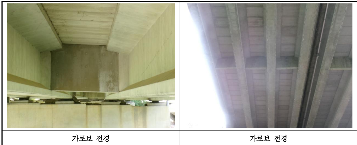
【사진 14.3.6】 가로보 전경
