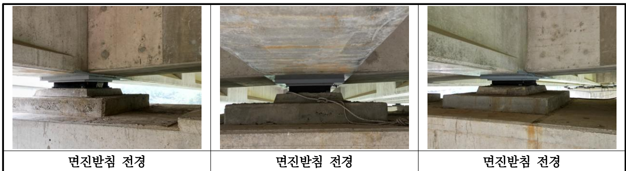
【사진 14.3.12】 교량받침 전경
