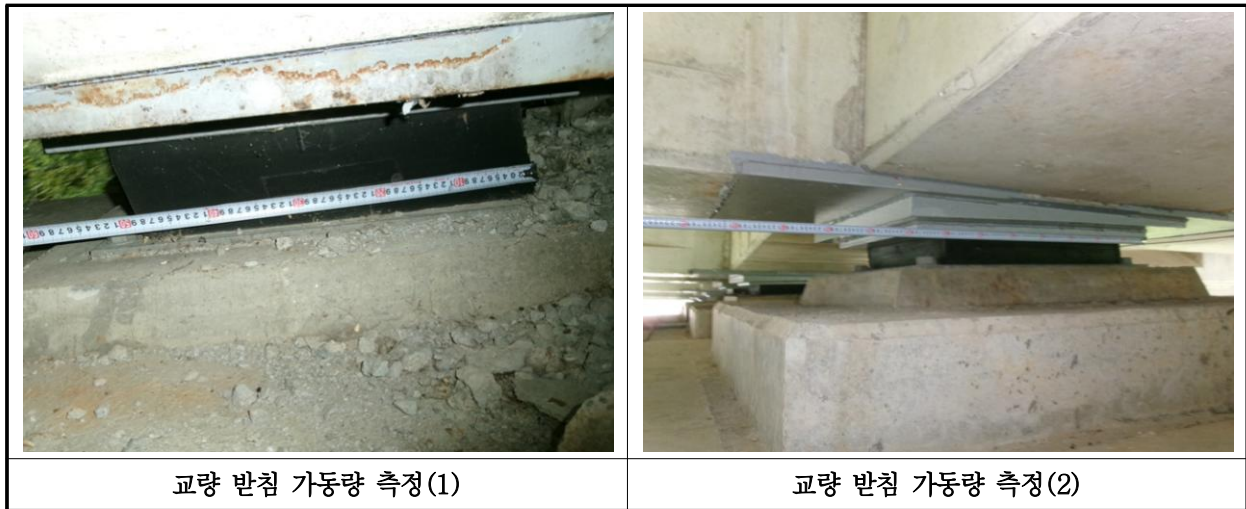
【사진 14.3.38】 교량받침 이동량 측정
