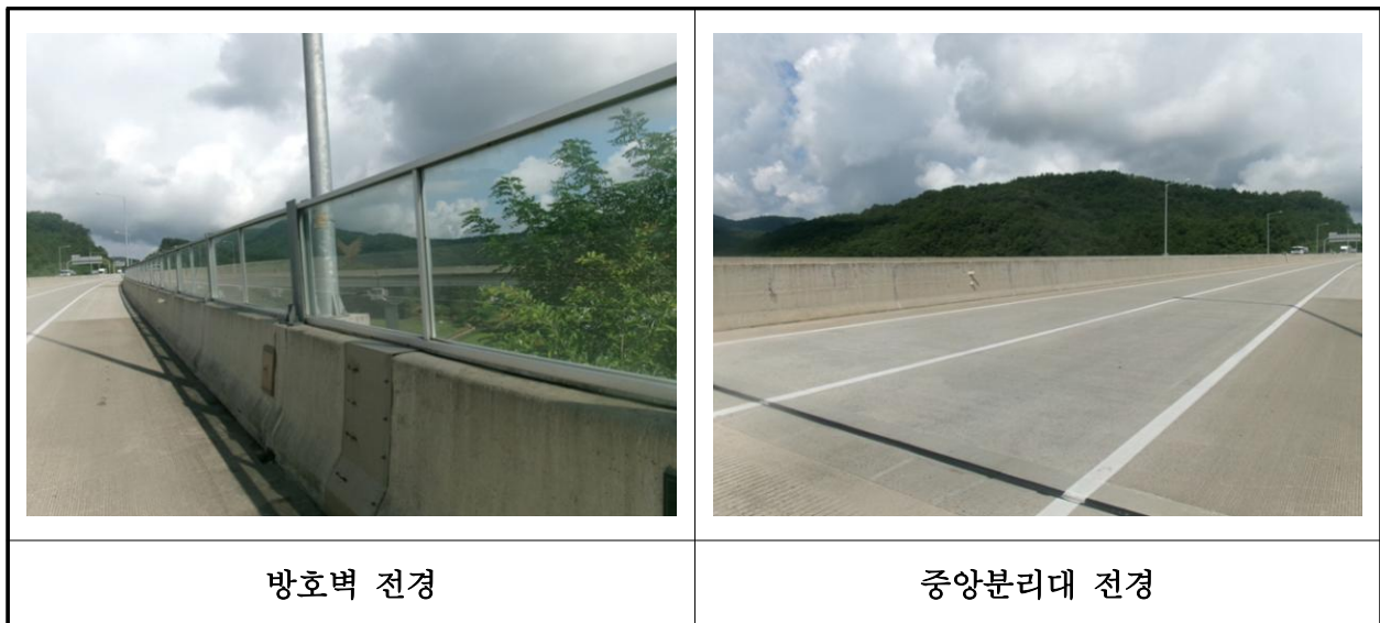
【사진 14.3.23】 방호벽 및 중앙분리대 전경
