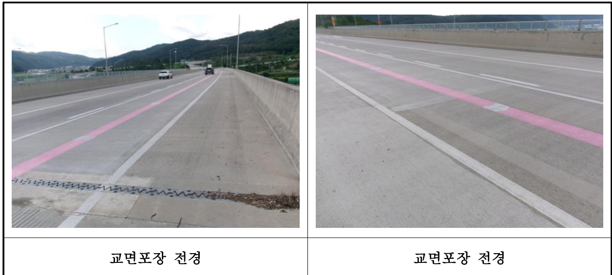
【사진 14.3.42】 교면포장 전경
