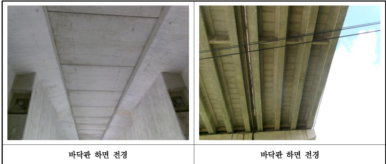
【사진 14.3.2】 바닥판하면 전경
