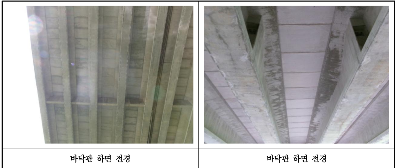
【사진 14.3.25】 바닥판하면 전경
