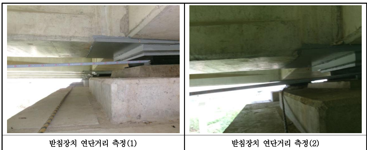
【사진 14.3.37】 교량받침장치 연단거리측정
