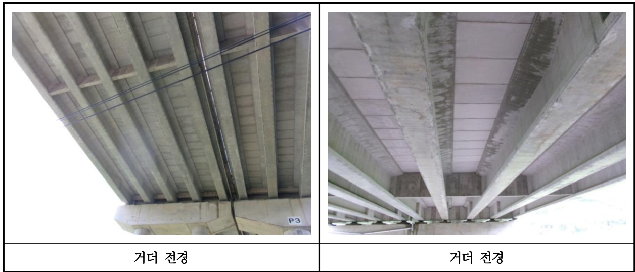
【사진 14.3.27】 거더 전경
