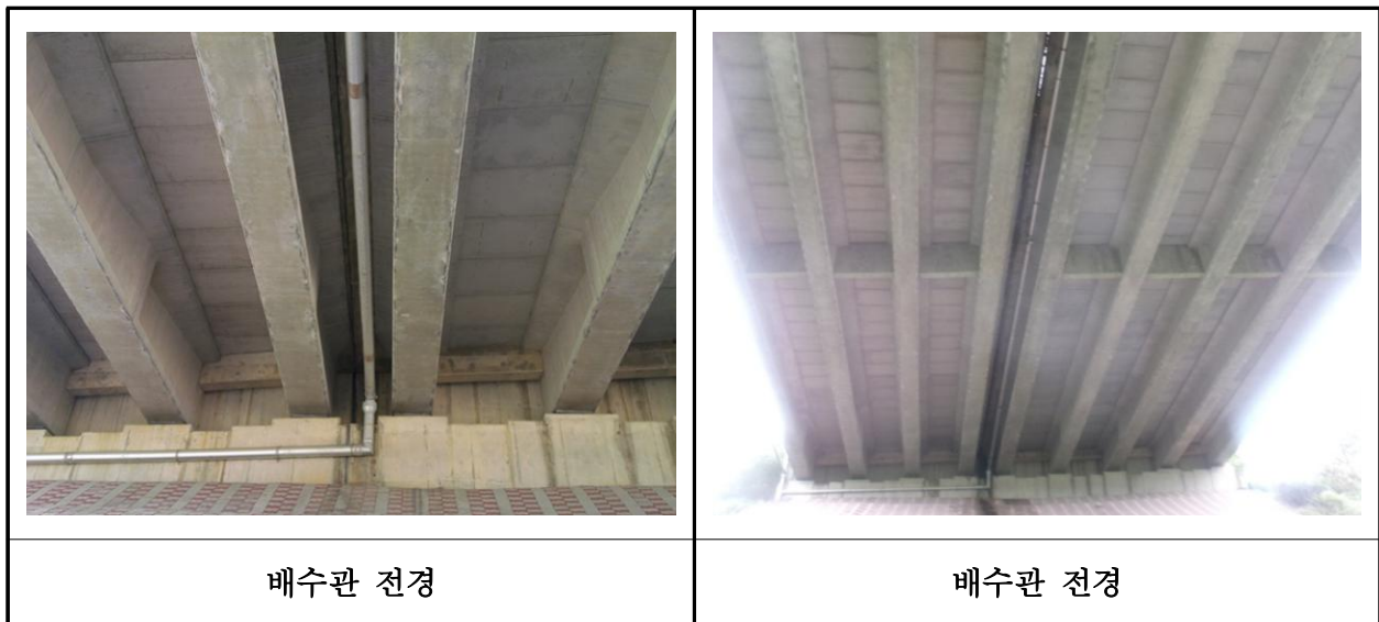
【사진 14.3.44】 배수시설 전경
