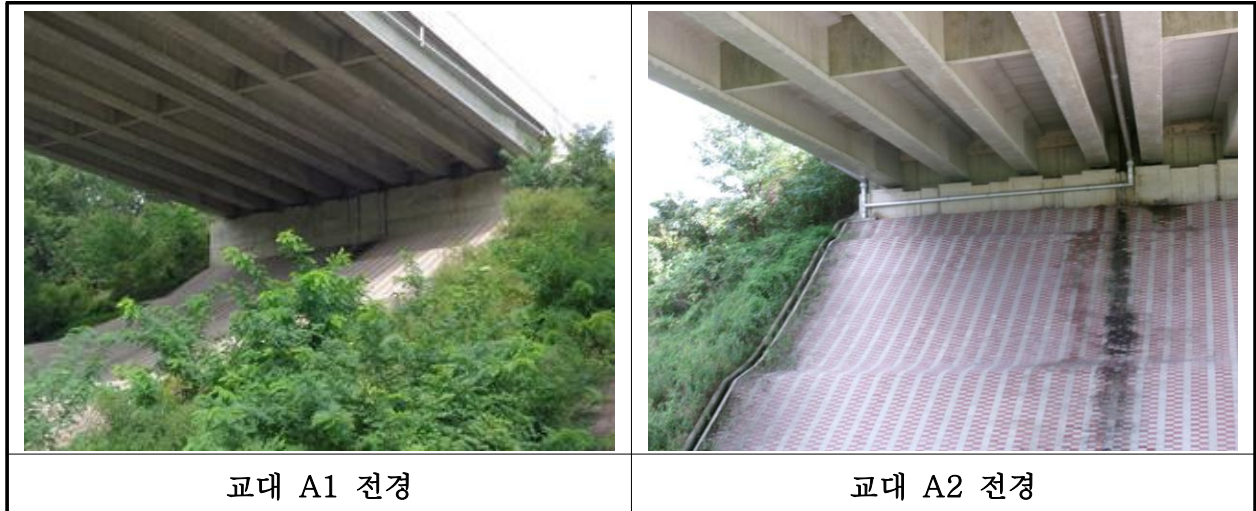
【사진 14.3.8】 교대 전경
