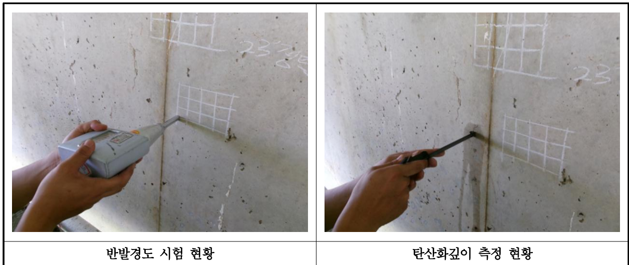
【사진 14.4.1】 콘크리트 내구성조사 현황
