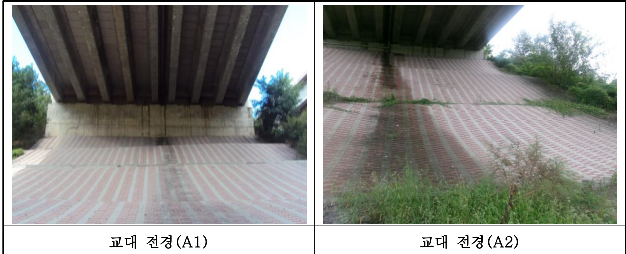
【사진 14.3.31】 교대 전경
