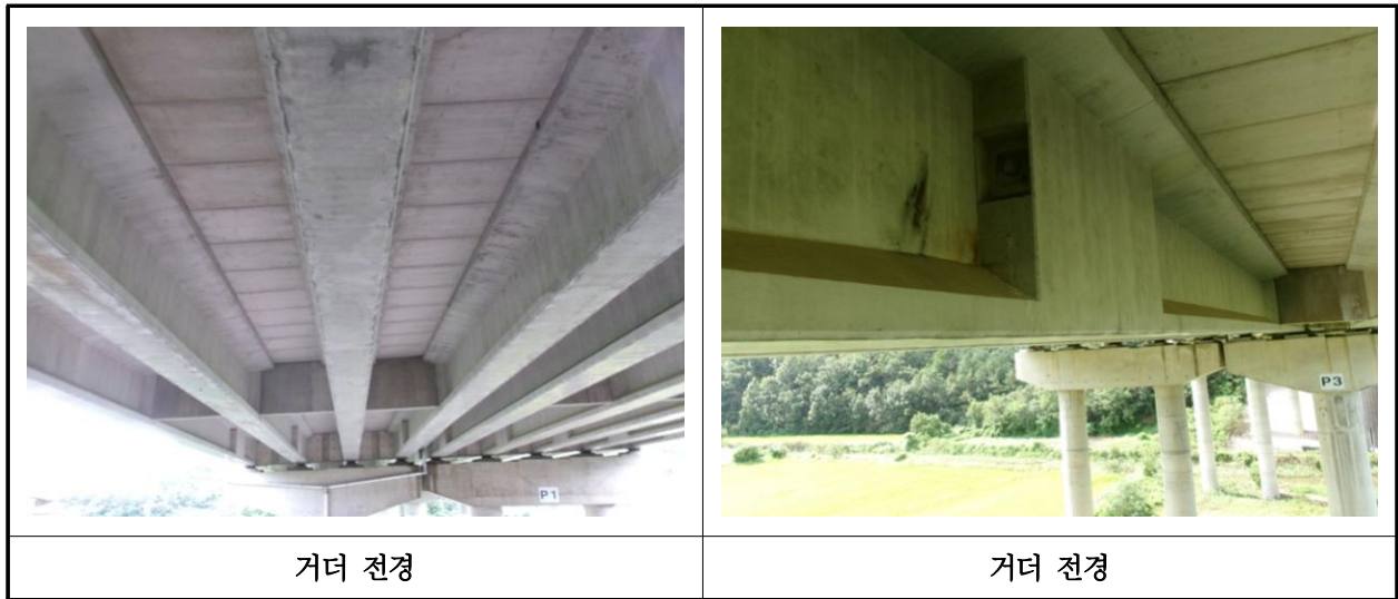
【사진 14.3.4】 거더 전경
