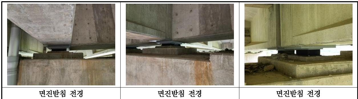
【사진 14.3.35】 교량반침 전경
